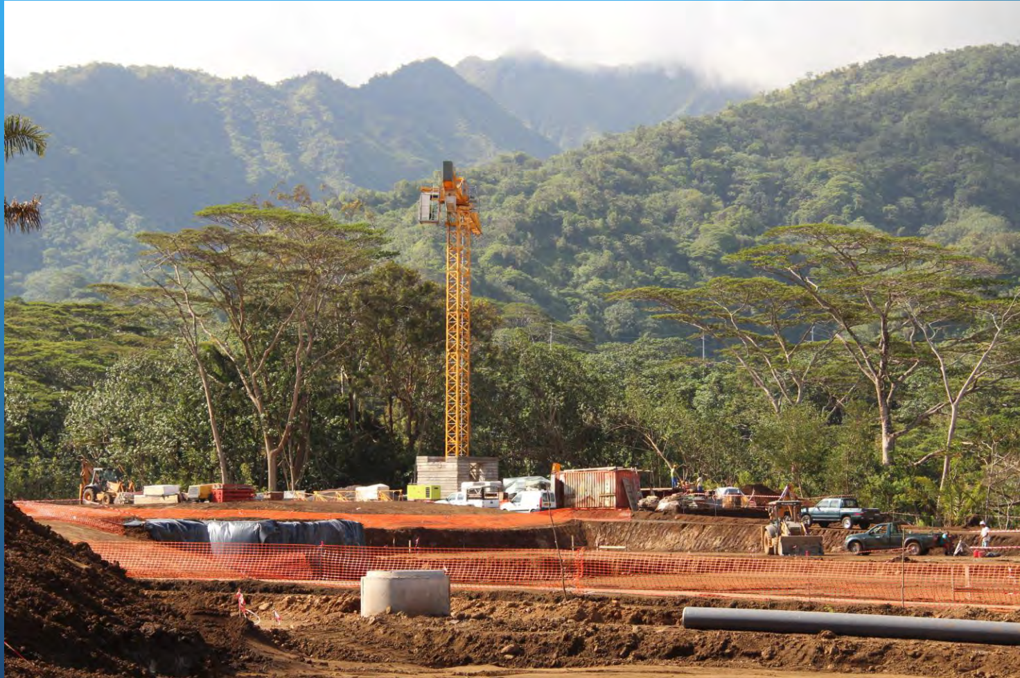
Chantier du futur centre pénitentiaire de la Polynésie française à Papeari
